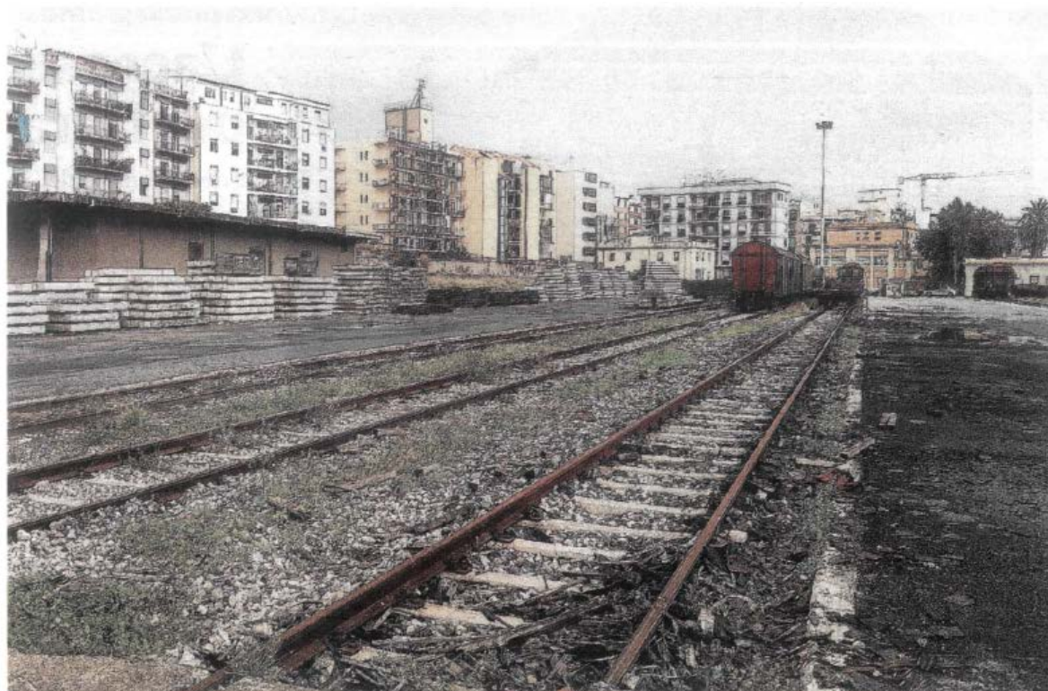
Quanto è irto di difficoltà il cammino per la nuova strada nelle aree morte di Messina. Lunedì una commissione deciderà se confermare, o meno, il termine del 7 settembre
